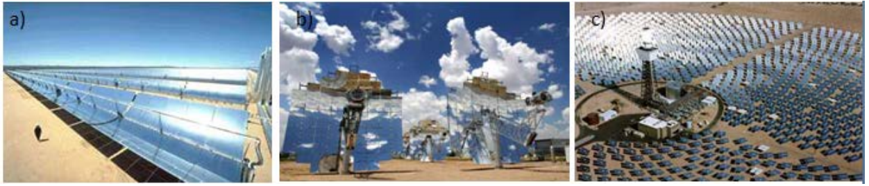
Şekil 1: Toplayıcı güneş enerji sistemleri a) parabolik-oluk, b) çanak-motor ve c) güç kulesi
