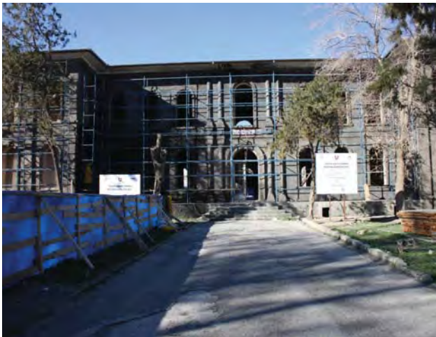
Proje öncesi Adliye B Binası
