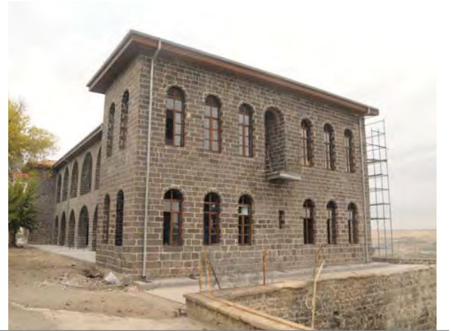
Proje sonrası Adliye A Binası
