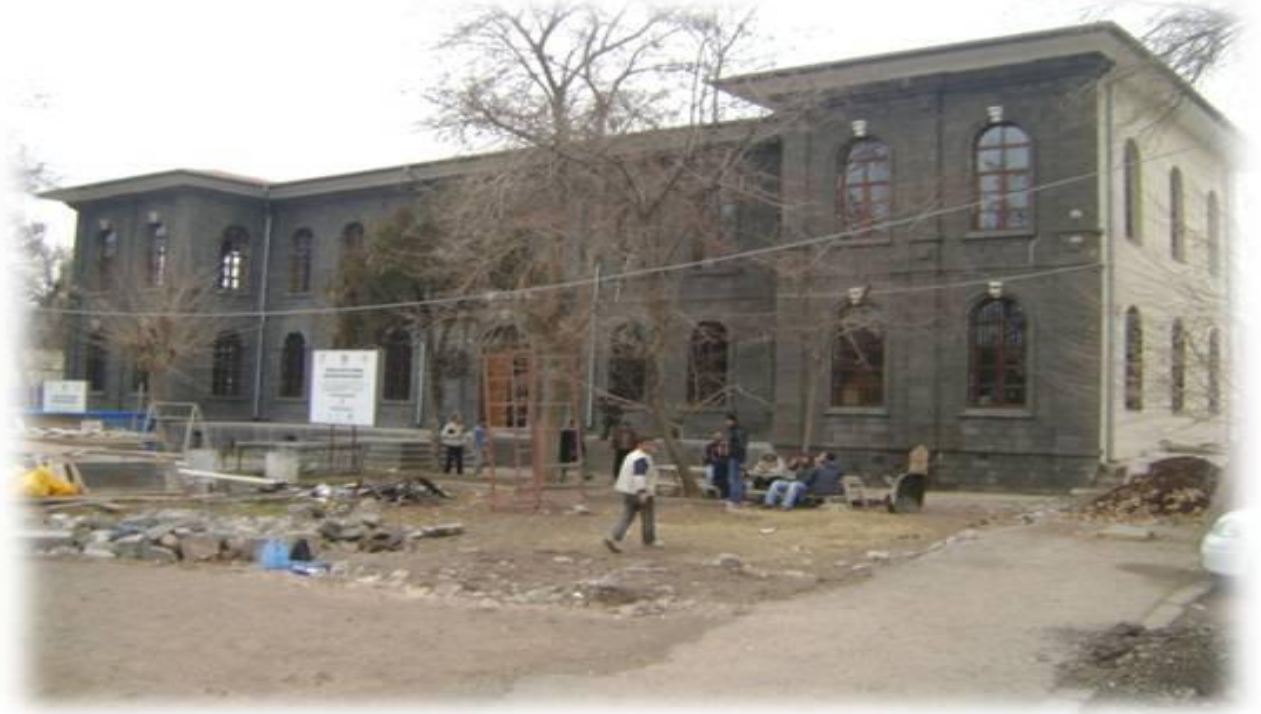
Proje Öncesi Adliye B Binası
