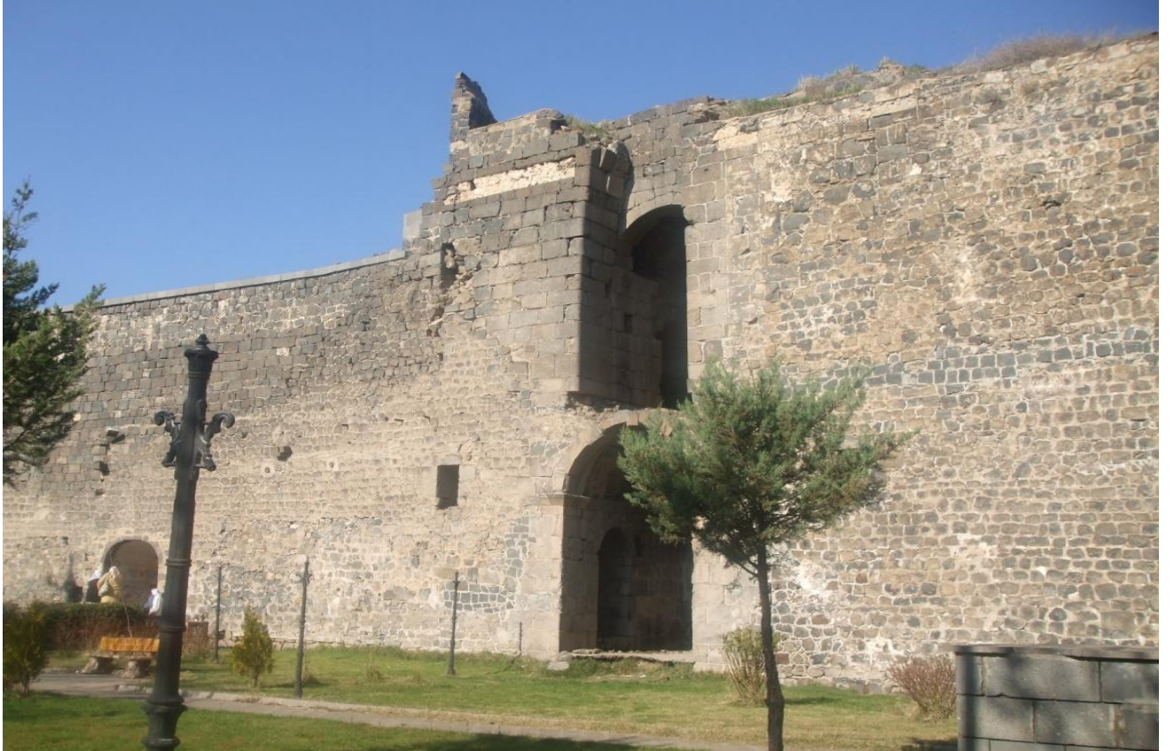
Diyarbakır Surları 2004 Yılı Onarımı
