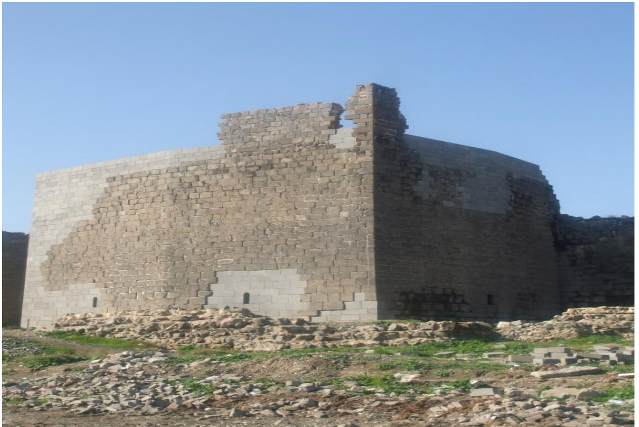
47 Nolu Burç Restorasyon Sonrası Görüntüsü
