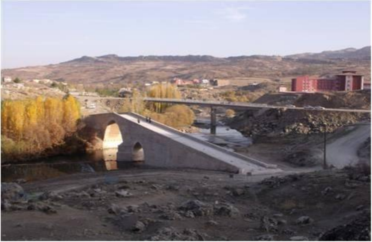
Haburman Köprüsü ve Proje Kapsamında Yanına Yapılan Yeni Köprü
