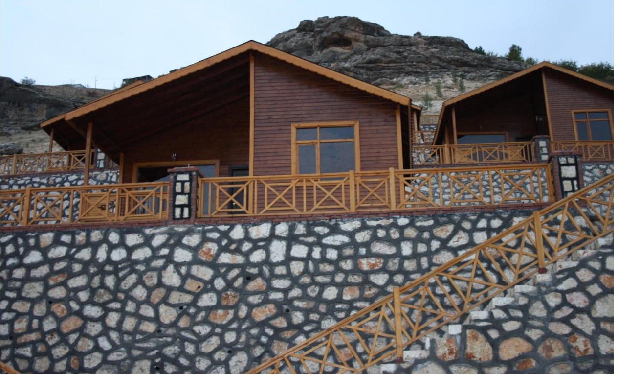
Proje Kapsamında Yapılan Bungalov Evler
