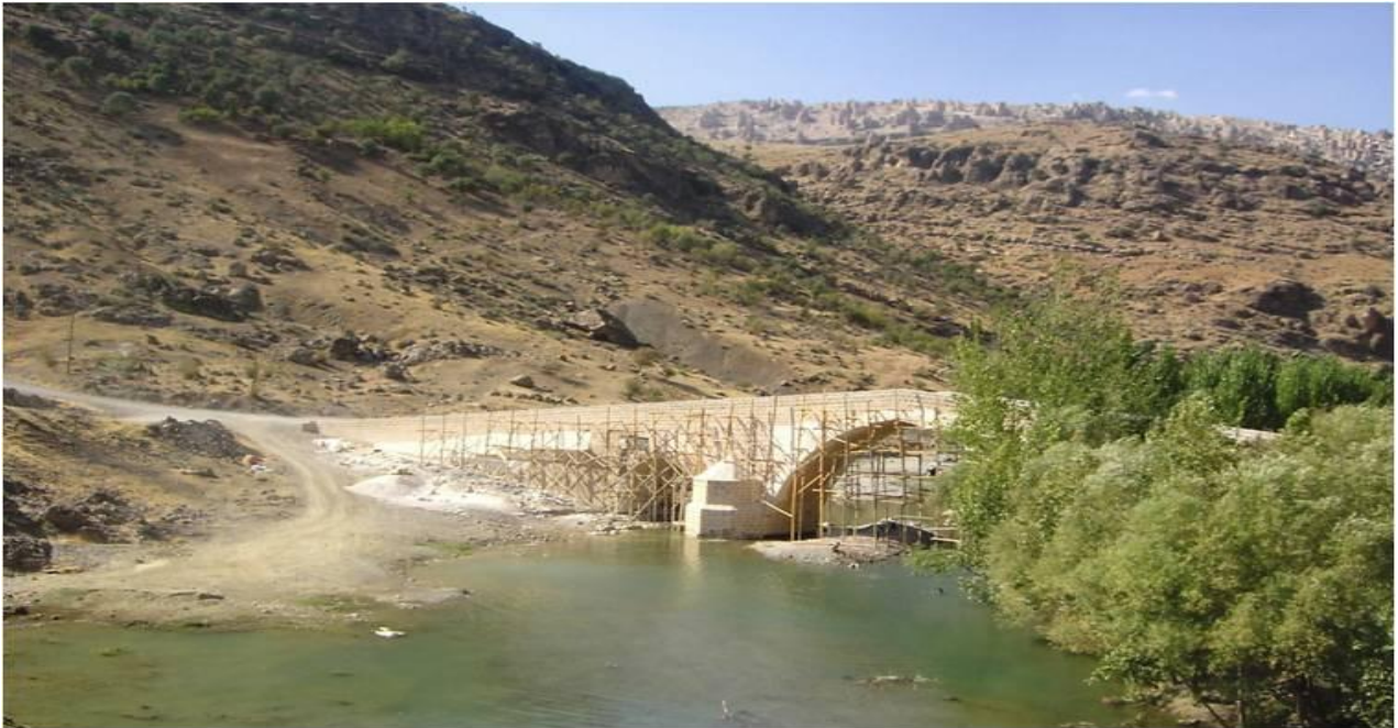
Restorasyon Çalışmalarından Bir Görüntü
