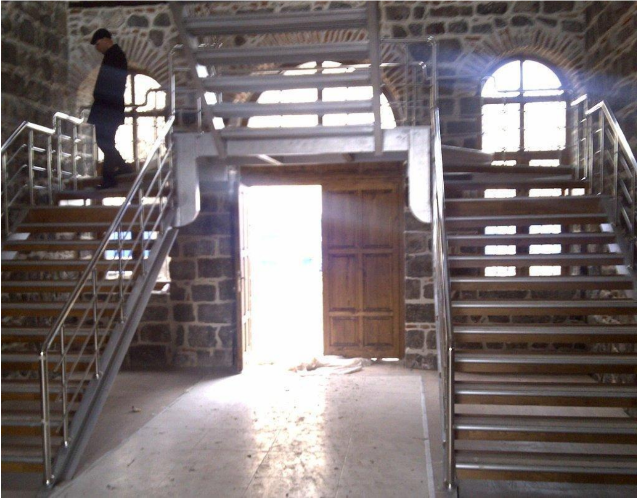
Adliye B Binası İç Mekandan Bir Görüntü
