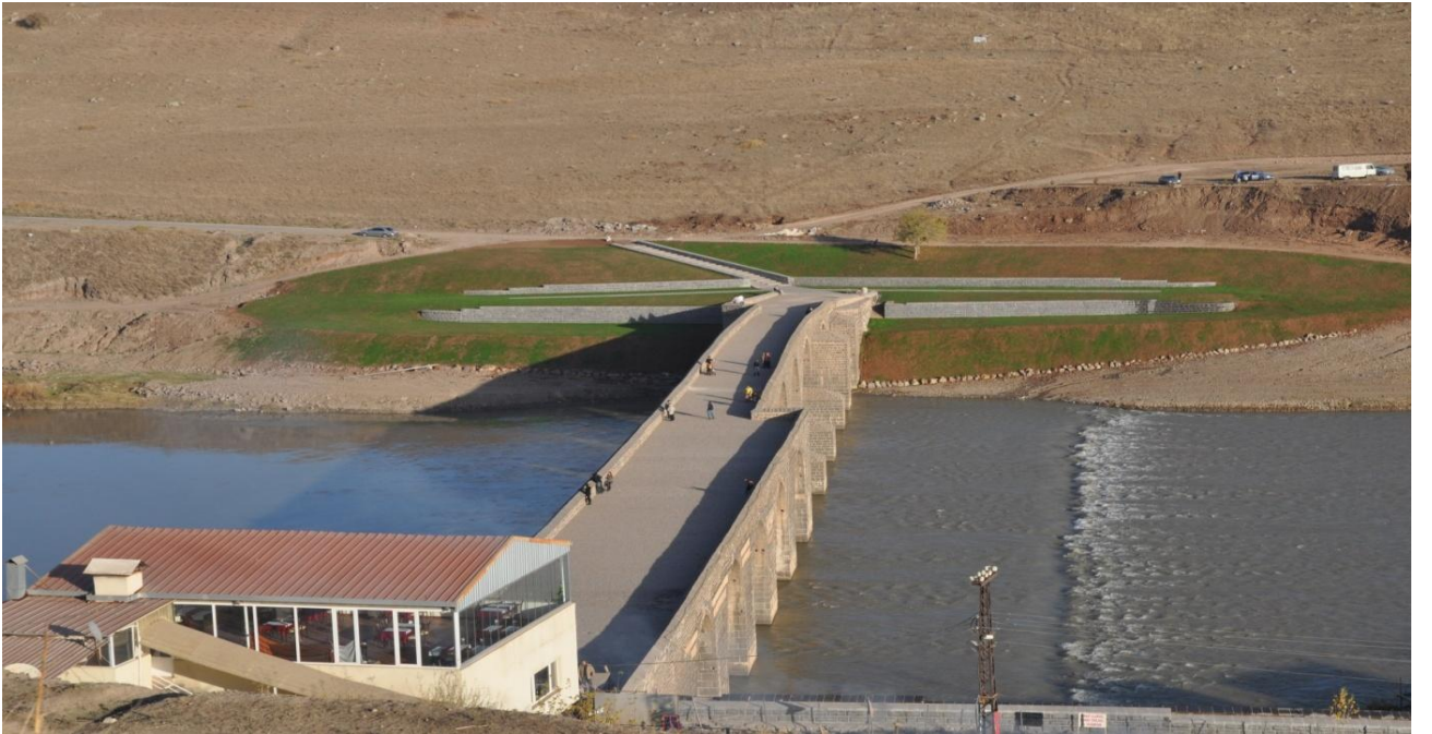
Proje Sonrası On Gözlü Köprü
