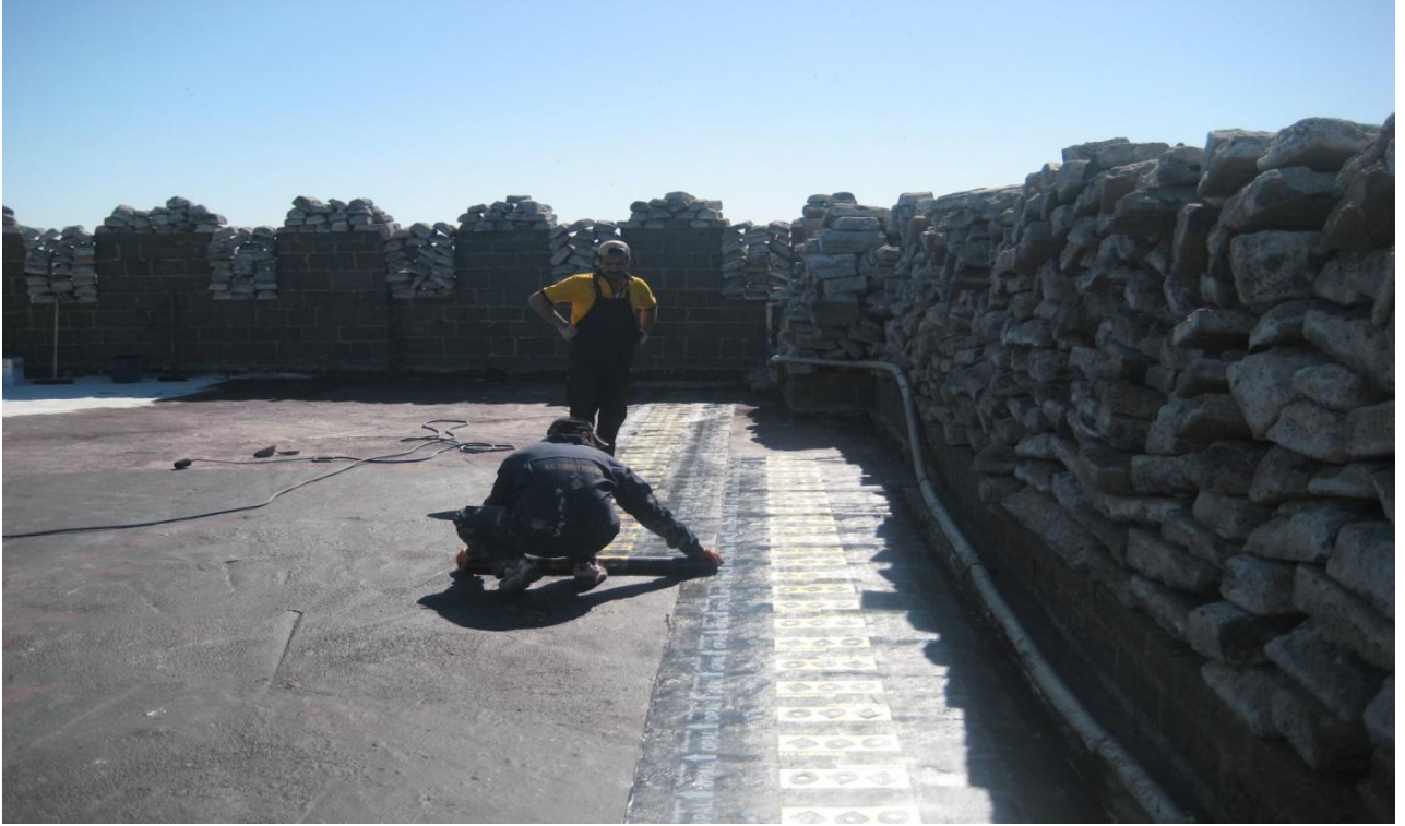
Dağkapı Burcu Restorasyon Öncesi
