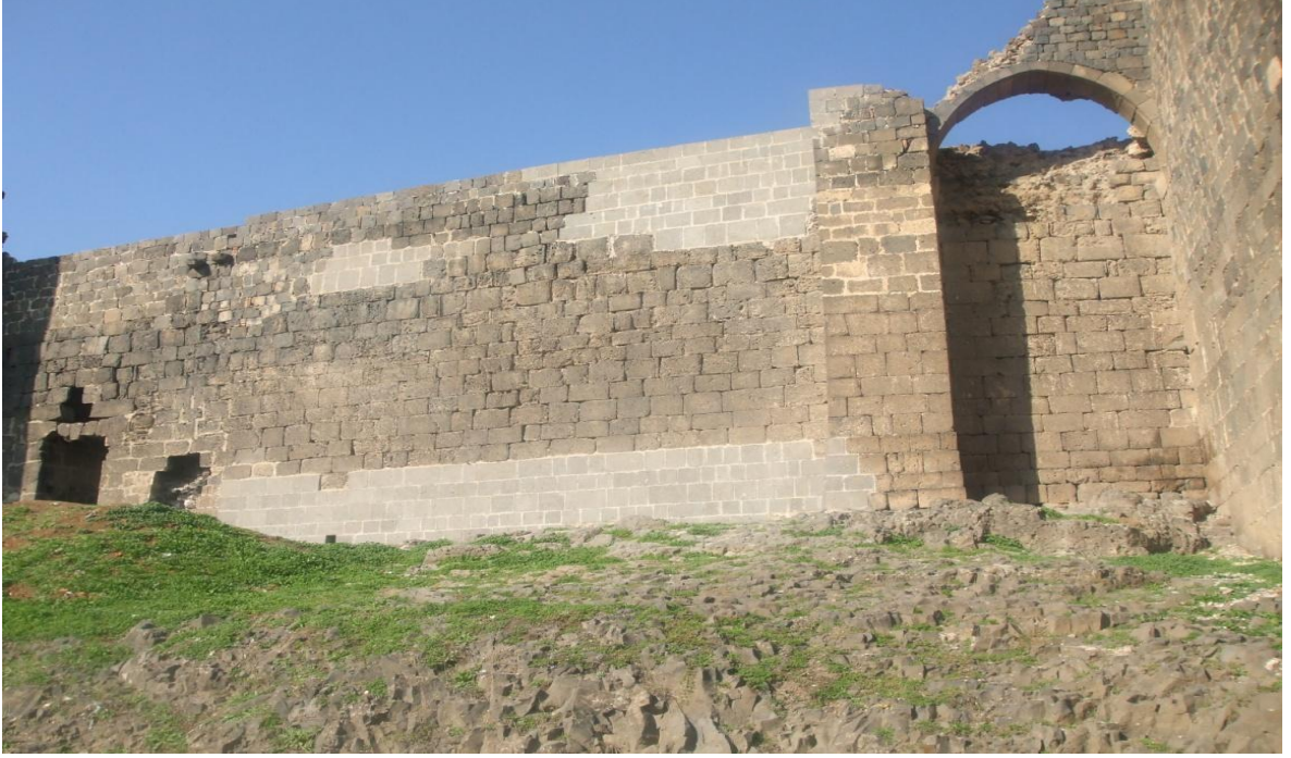
Diyarbakır Surları 2005 Yılı Onarımı
