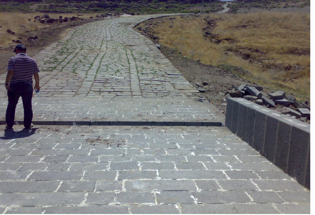
Proje Kapsamında Restorasyonu Yapılan Antik Yol
