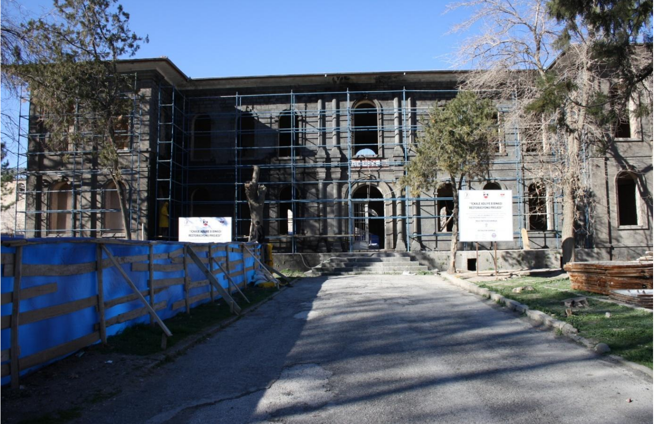
Adliye B Binası Restorasyon Çalışmalarından Bir Görüntü
