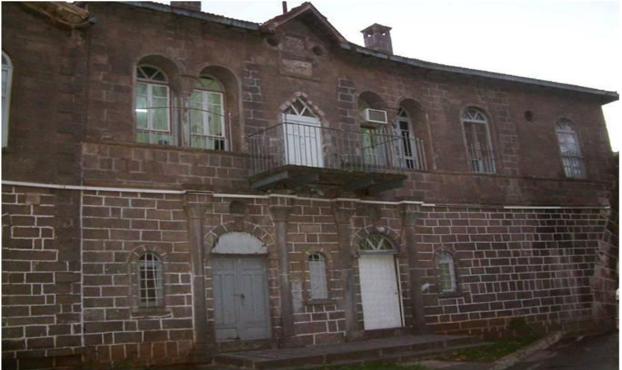
Proje Öncesi Müze Müdürlüğü Binası
