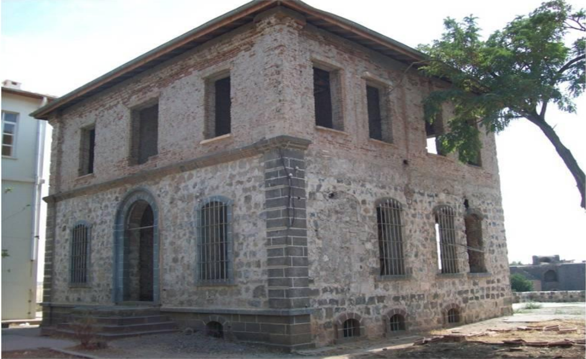
Proje Öncesi Cephanelik Binası
