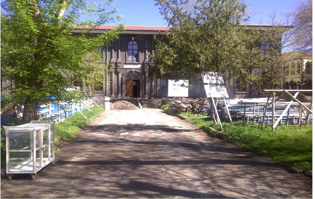
Proje Sonrası Adliye B Binası
