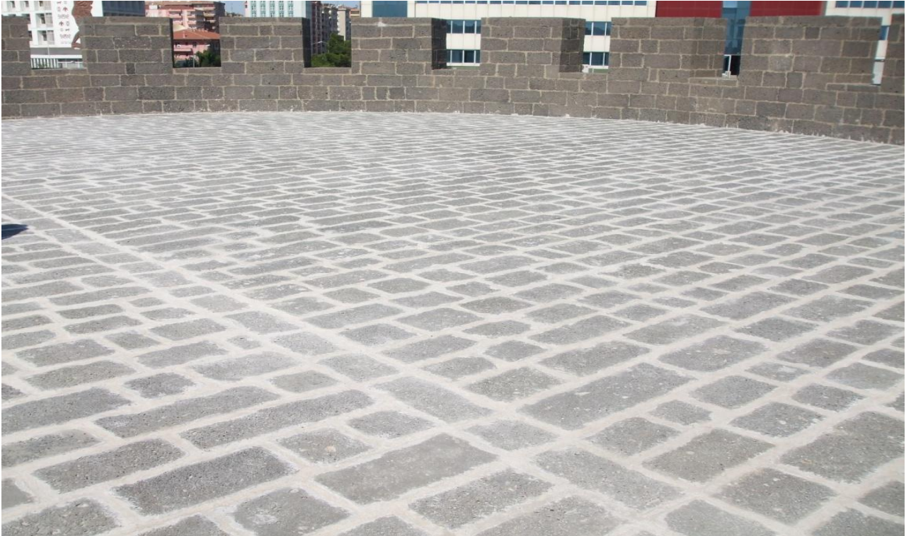
Dağkapı Burcu Restorasyon Sonrası
