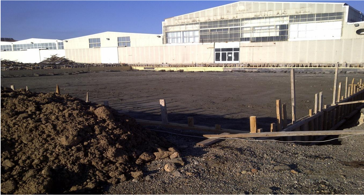
Proje Kapsamında Yapılan İnşaat Çalışmalarından Görüntüler
