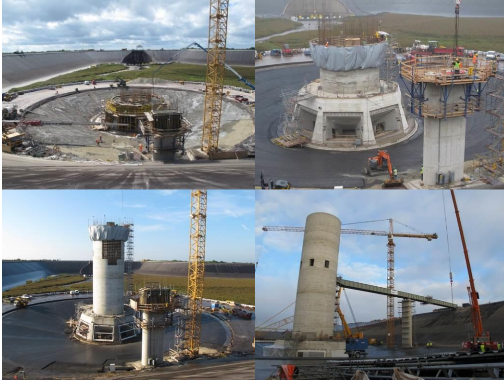
Şekil 8 – Giriş Yapısı İnşaat (Proje Machine 11, PSW Vianden)
