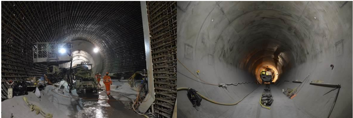
Şekil 12 – Basınç Kuyusu Beton Kaplama İşlemi (PSW Limmern)
