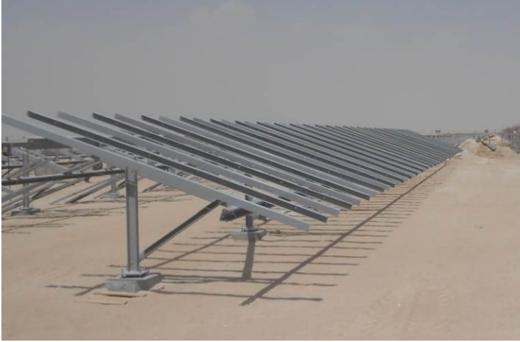
Şekil 32 – Tek Kutuplu Altyapı Konstrüksiyonu Örneği
