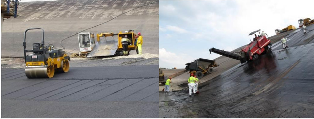
Şekil 7 – Asfalt Betonlama Uygulaması (Projekt Maschine 11, PSW Vianden)
