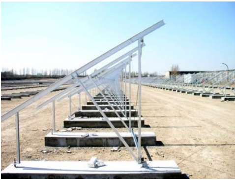
Şekil 31 – Beton Kalıplarına Dizme
