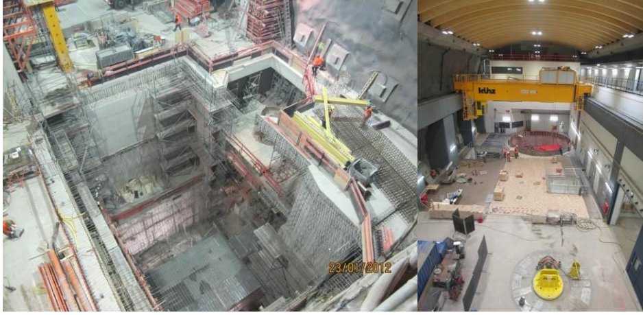
Şekil 14 – Yeraltı Kontrol Merkezi İnşaatı (Proje Machine 11, PSW Vianden)
